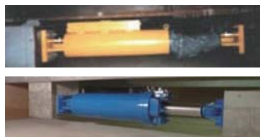
免震用オイルダンパーと 新開発ロックダンパー (竹中工務店・KYB共同開発)
