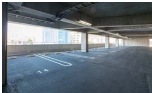
全区画屋根付き居住者用駐車場
